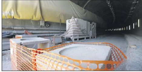
La route qui relie la France et l'Italie via le tunnel de Tende sera fermée du lundi 19 au jeudi 22 juin. (Photo Frantz Bouton)
