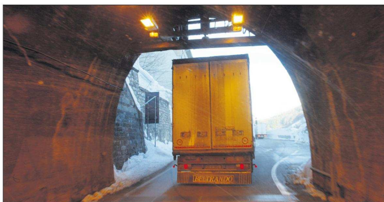
Le passage de certains poids lourds dans le tunnel de Tende est en sursis. (Photo archives E. D.)
